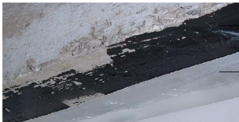
Bild 1 (Leibung geprimert mit Multi-Primer)
