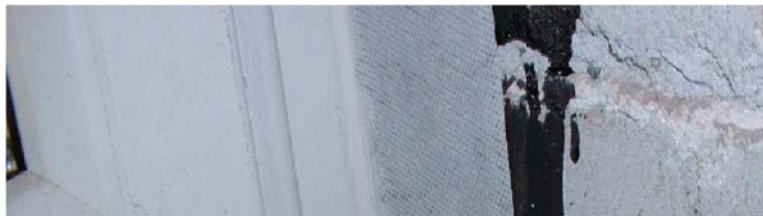
Bild 5: Eckausführung bei Version „A-Mono“. Immer wenn ein neuer Streifen in den Ecken mit einem schon montierten Streifen des Anschlussbandes überlappt, wird wieder WFlex-TFS oder WFix-Kleber auf das schon montierte Band aufgebracht, sodass auch die Enden des neuen Bandes fest in den Kleber eingedrückt werden können und die Band-Enden vollständig im Kleber eingebettet sind.
