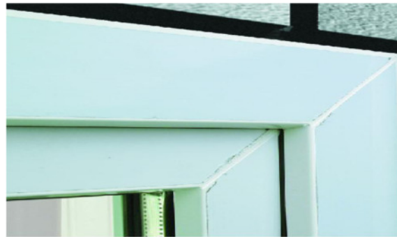
Bild 3: Fensterrahmen vor Montage der Fensteranschlussbänder „Mono“
