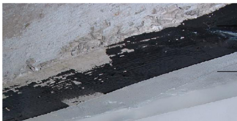
Bild 1 (Leibung geprimert mit Multi-Primer)
