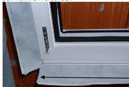
Bild 4: Eckausbildung durch Anbringen eines WFlex-TFS oder WFix- Kleberpunktes und Zusammenkleben der Spezialklebestreifen.
