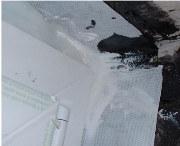
Bild 5: WFlex-TFS oder WFix zur Eckabdichtung. Die Band-Enden werden fest in den Kleber eingedrückt.
