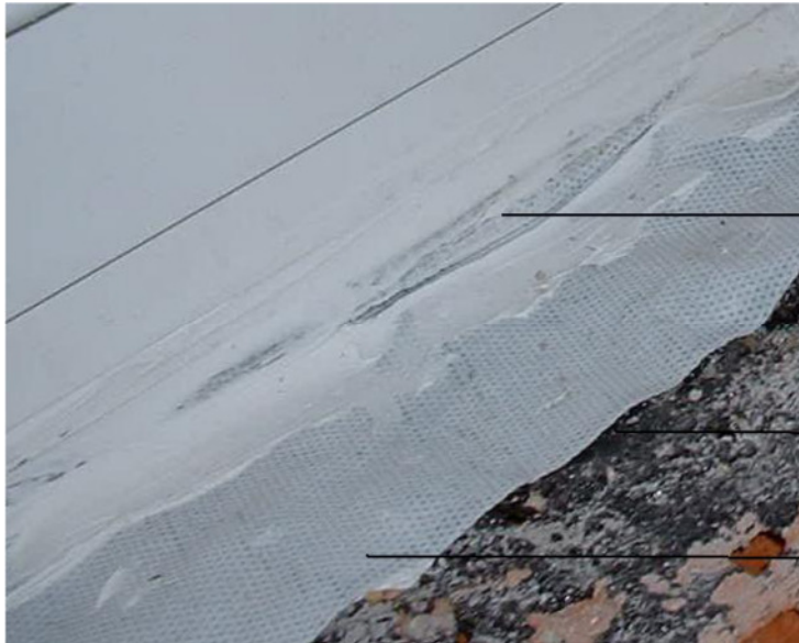
Bild 6: Montage der Bänder auf der Leibung:
