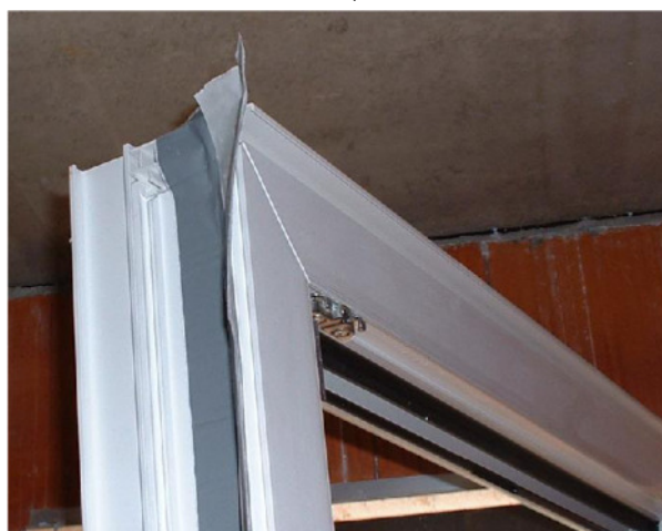
Bild 3: Montage von Fensteranschlussband „A-Duo“ auf der Rahmenstirn- seite mit ca. 5-10 cm Überstand an den Ecken
