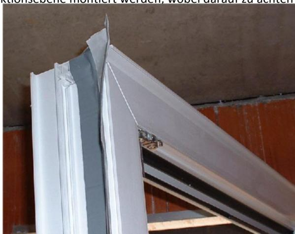
Nun werden direkt an den, an den Rahmeneck(schnitt)punkten überstehenden Bändern, Kleberpunkte unseres WFlex-TFS oder WFix-Klebers angebracht und ausgehend von diesen Stellen die überstehenden Bändern mit dem Spezialklebestreifen zusammengeklebt. Damit sind die Bänder auch an den Ecken zuverlässig dicht mit dem Rahmen verbunden
